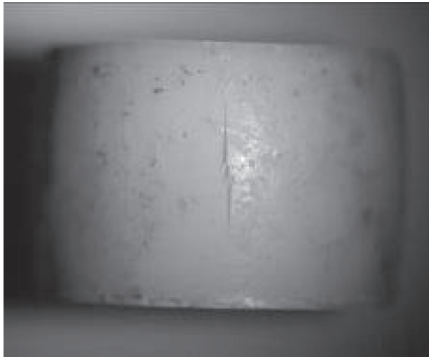
a) N5, slight longitudinal crack
